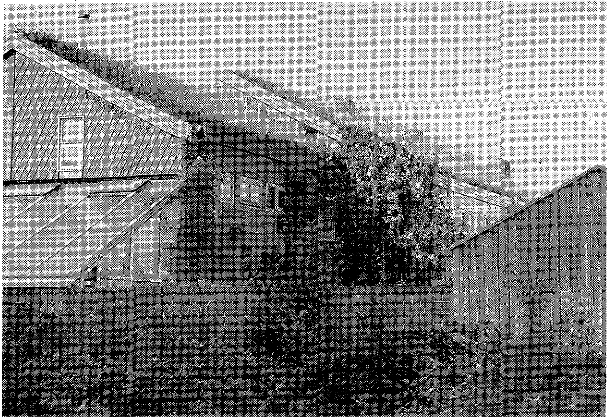
Lotissement avec toit herbeux "Laher Wiesen" à Hannover (RFA)
